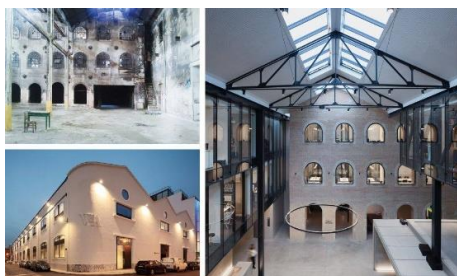
Figura 7: Cais do Sodré: sede do escritório de advocacia Vieira de Almeida, com um antes e depois do espaço interno.
