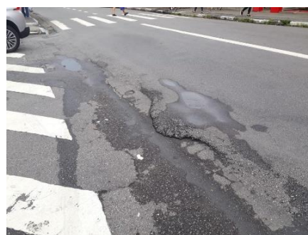
Figura 15: Vista da pavimentação da Rua Antônio Agú. Fonte: Arquivo Pessoal.
