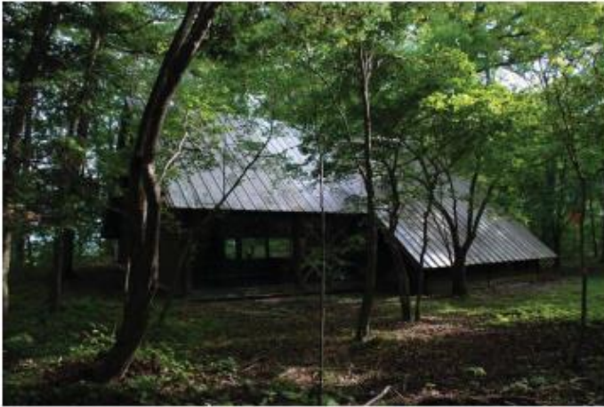
Figura 7: Casa Tanikawa, fachada norte (entrada) Fonte: Fonte: (BOSCH, 2015, p. 202)
