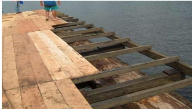
Figura 6: Montagem da base de uma habitação flutuante como sistema de flutuação a partir de toras de assacú – Sistema de montagem de vigas
