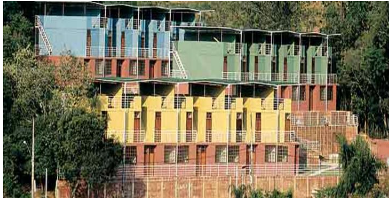
Figura 04 – Condomínio Cotia – Fachada Original
