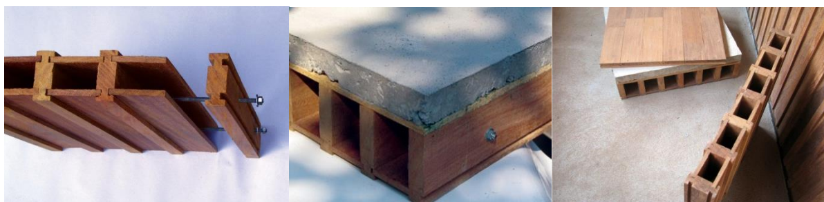
Figura 03 – Painéis paredes e laje
