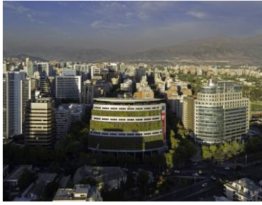
Fig.09 vista da fachada sul, maior incidência do sol.
