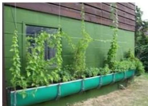
*Imagem 7: Edifício com Brise Vertical instalado.*
