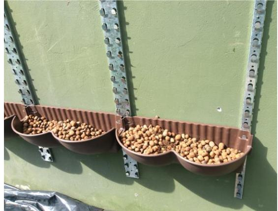
Imagem 3: Detalhe de instalação do Sistema Mamute com uso de argila expandida. Fonte: <https://s-media-cacheak0.pinimg.com/236x/79/17/ef/7917ef73fd436feaa98a6481b1e29d36.jpg>. Acesso em: 9 Agosto 2016.
