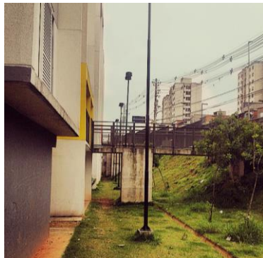
Figura 7: Passarelas de acesso
