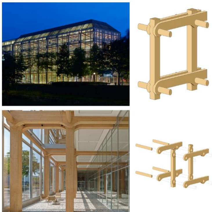
Figura 2 – Edifício Tamedia, projeto Shigeru Ban Architects (Zurique, Suíça). Foto noturna externa do edifício, assim como corredor interno com ênfase para a estrutura em madeira. Detalhe dos encaixes utilizados e sua montagem.
