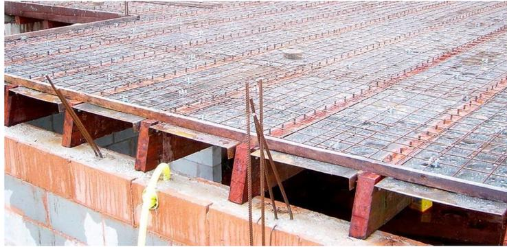
Figura 7 - Estrutura mista de laje de concreto moldada *in loco* nas vigas de madeira, apoiadas no muro de alvenaria - Fonte: arquivo pessoal Marcos Acayaba
