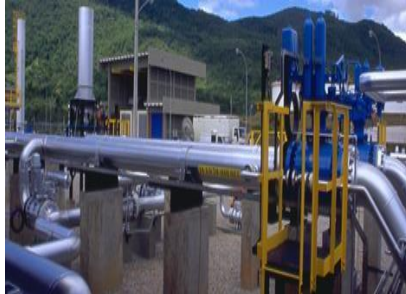
Figura 11 - gasoduto Brasil-Bolívia (Petrobrás)
