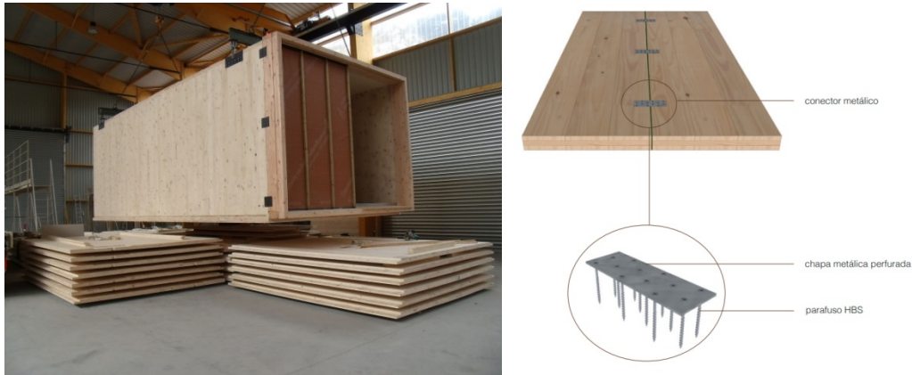
Figura 6. Montagem da cápsula em fábrica. Fonte: PYRÉNÉES CHARPENTES.
