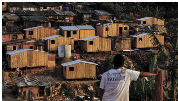
Figura 9. Casas do TETO construídas em comunidade carente. Fonte: TETO, 2016.
