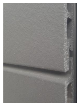
Figura 8: Detalhe Junta aberta e encaixe
