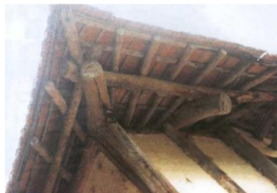
Figura 9- "Ougi-daruki", beiral com cachorro não paralelo em formato de leque. Fonte:Kunikazu.
