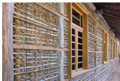
Figura 1- Restauro das paredes de taipa. Fonte: Mori.
