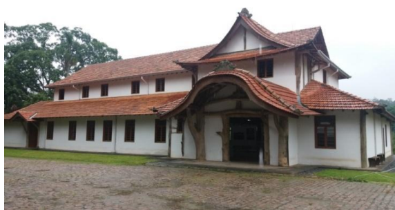
Figura 4- Vista frontal. Fonte: Juliana Tie Alves, 2017.
