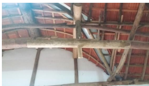
Figura 11- Viga parcialmente substituída, perceptível pela diferenciação de coloração da madeira. Fonte: Juliana Tie Alves, 2017.
