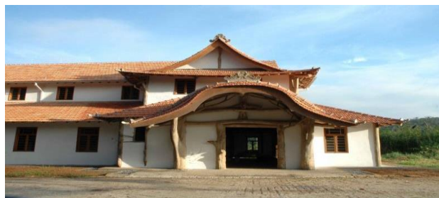
Figura 10-Telhados nokikarahafu e Irimoya no Casarão do Chá. Fonte: Associação Casarão do Chá.
