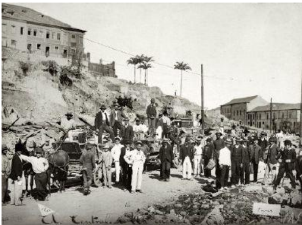
Figura 2: demolição Morro do Castelo em 1904
