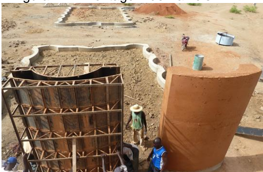
Figura 12 – Montagem de Painéis
