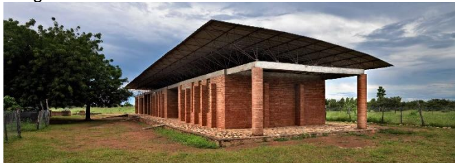
Figura 5 – Escola Primária de Gando
