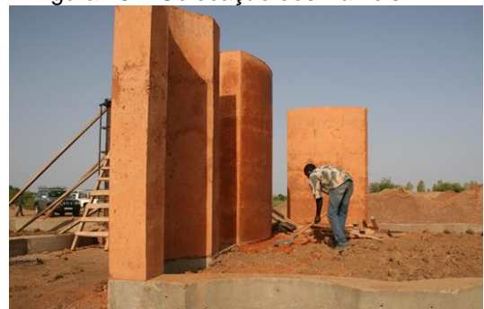
Figura 13 – Colocação dos Painéis
