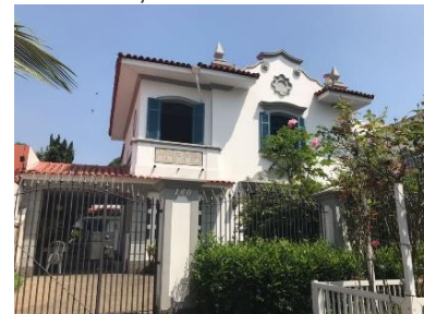
Figura 6: Residência Neocolonial Rua Cuba, 160.
