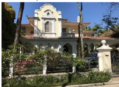
Figura 4: Residência Neocolonial Rua Peru, 71.
