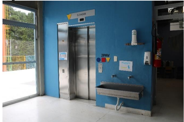
Figura 16: Elevador da escola.
