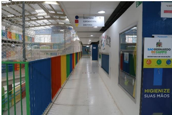
Figura 9: Corredores laterais da escola.
