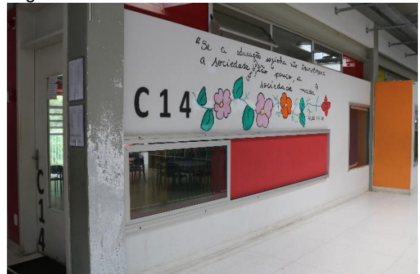
Figura 10: Corredores laterais da escola.
