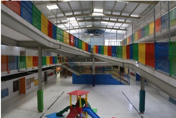
Figura 15: Rampas da escola.
