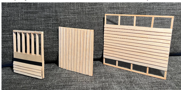
Imagem 9 - Painéis de vedação (face externa) do wood frame, da palafita tradicional e da palafita com adaptações de sustentabilidade, na ordem disposta
