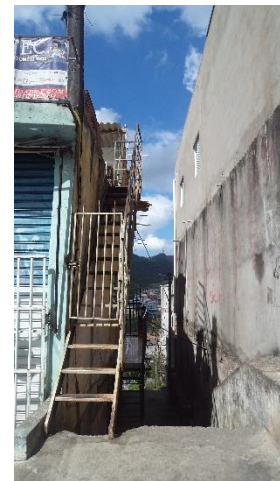
Figura 8: Servidão de passagem com escada metálica para acesso de construção vizinha.
