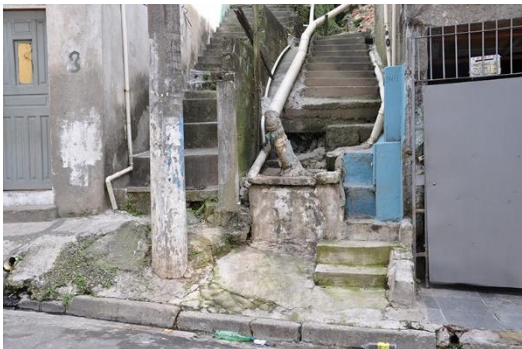
Figura 2: foto situação atual escadaria na favela Guilherme Bude. Fonte: H+F arquitetos
