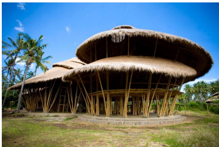
FIGURA 3- Green School em Bali, com fundação de concreto e estrutura de bambu.
