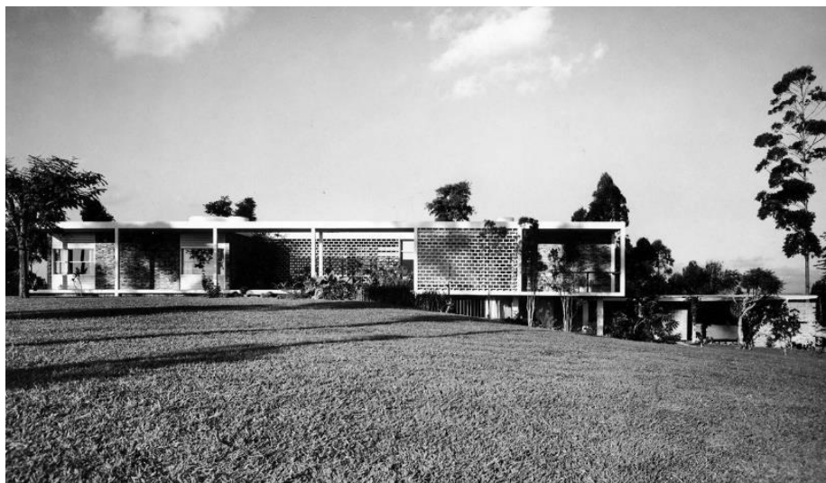
Figura 2 - Utilização de cobogó na Residência do Morumbi de Oswaldo Bratke
