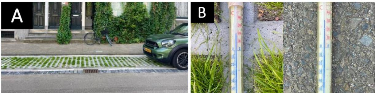
Figura 11: A) Calçadas implementadas com cobogós que em suas aberturas são cobertas por grama, e não apenas de asfalto, B) Variação de temperatura entre as vagas com grama e as de asfalto, concluindo a diminuição quando colocado a grama.
