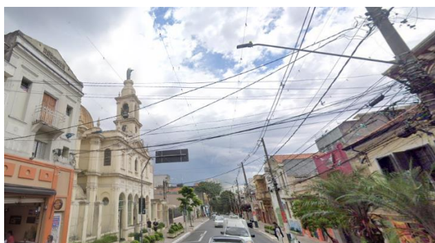
Figura 14 – Vista da paróquia tombada Nossa Senhora da Achiropita obstruída pela fiação aérea
