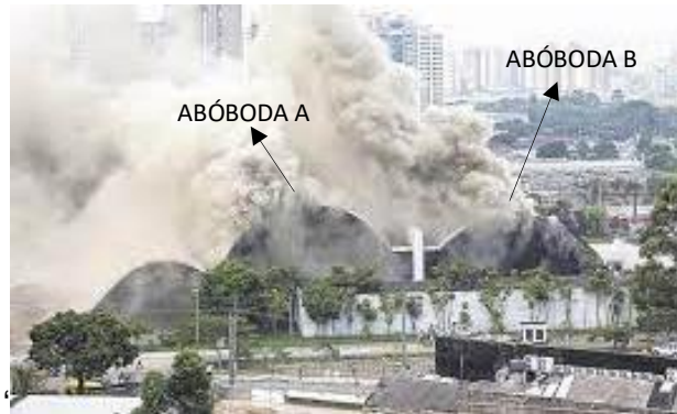
Figura 2 Auditório em chamas durante incêndio
