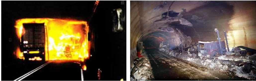
Figura 1 Estruturas de túneis sujeitas a incêndios de grandes proporções (esq.) Túnel Mont Blanc após sinistro; (dir.) Túnel San Gotardo.
