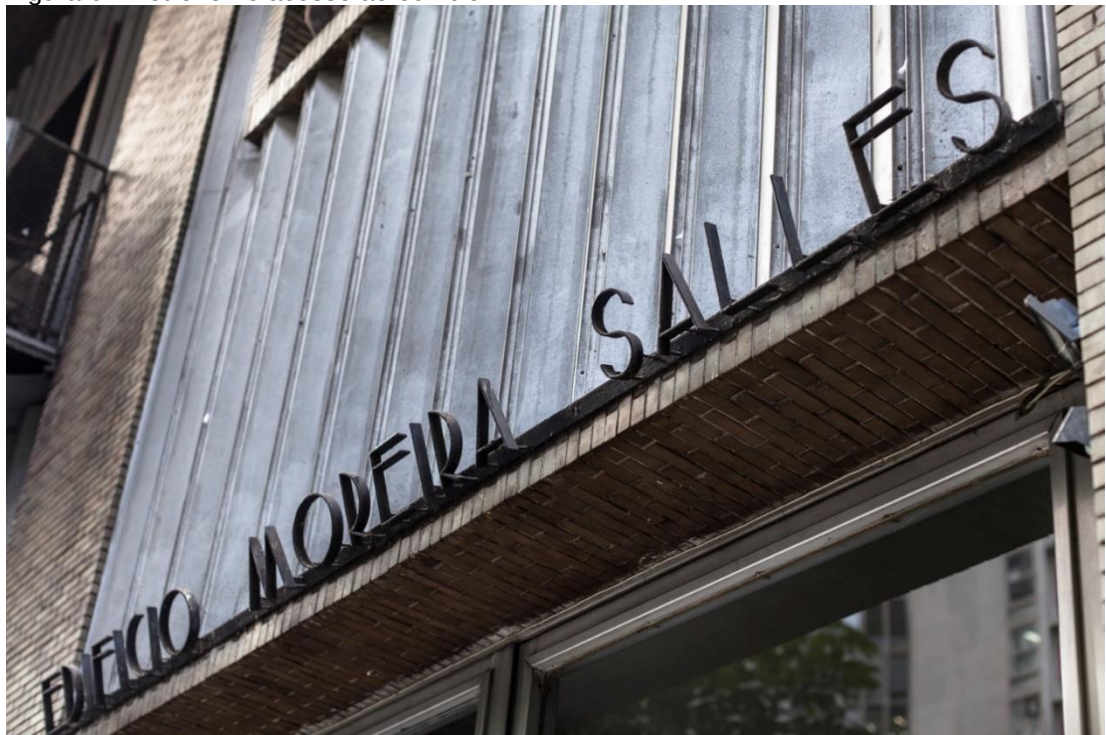
Figura 6 – Letreiro no acesso ao edifício
