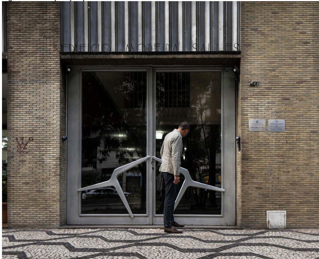
Figura 5 – Composição plástica do acesso ao edifício
