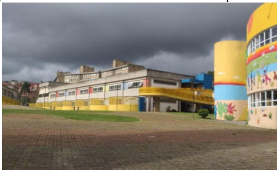
Figura 3: Fachada do CEU EMEI Paraisópolis
