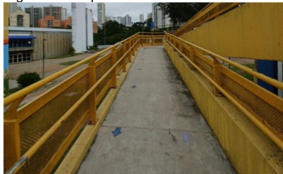
Figura 4: Rampa de acesso
