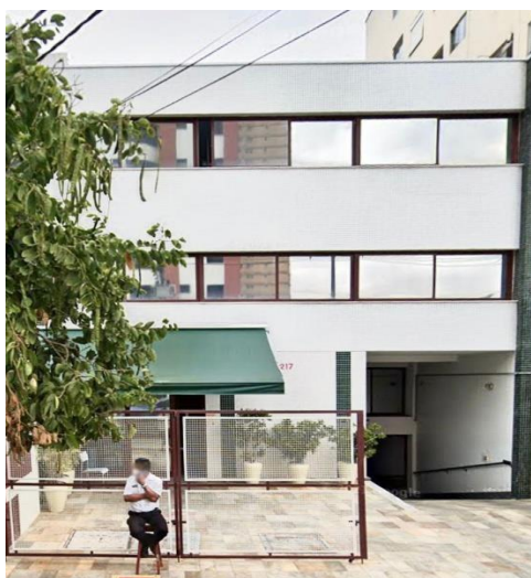
Figura 1: Visão Externa da Entrada da clínica
