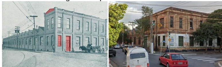
Figura 14: Imagem do edifício publicada em 1922 e situação em 2019, com grifo do autor nos elementos que foram retirados ao longo do tempo.
