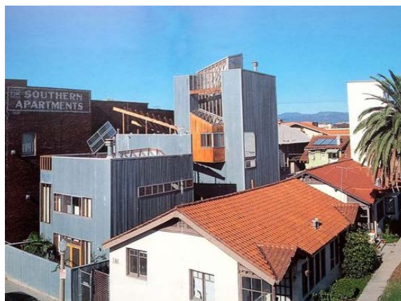
Figura 5. Foto Casa Spiller
