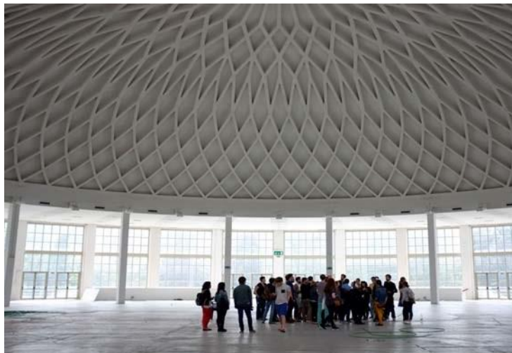
Figura 1 Abóboda do Centro de Exposições de Turim (inaugurado em 1950) Fonte: PLN Project Association
