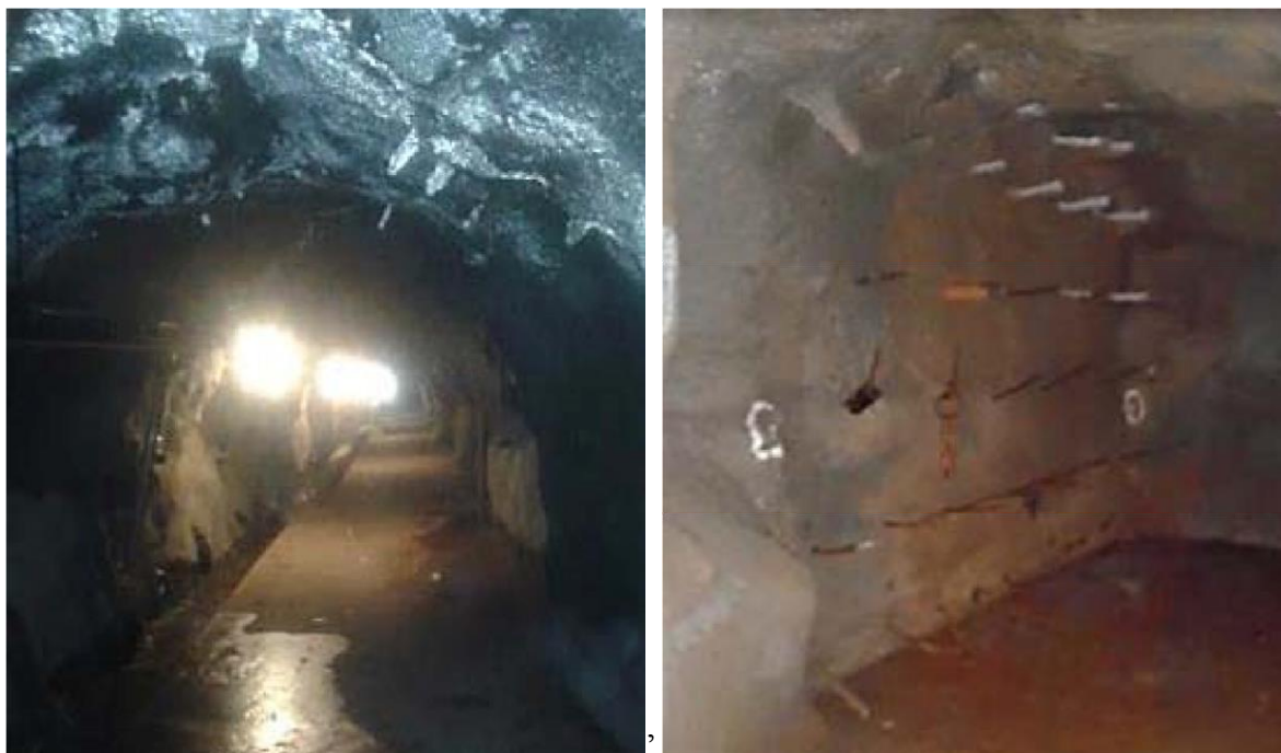
Fotografia 1 Estrutura de reforço (a) túnel perimetral na fundação (b) chaveta na fundação da barragem principal (El. 20m)
