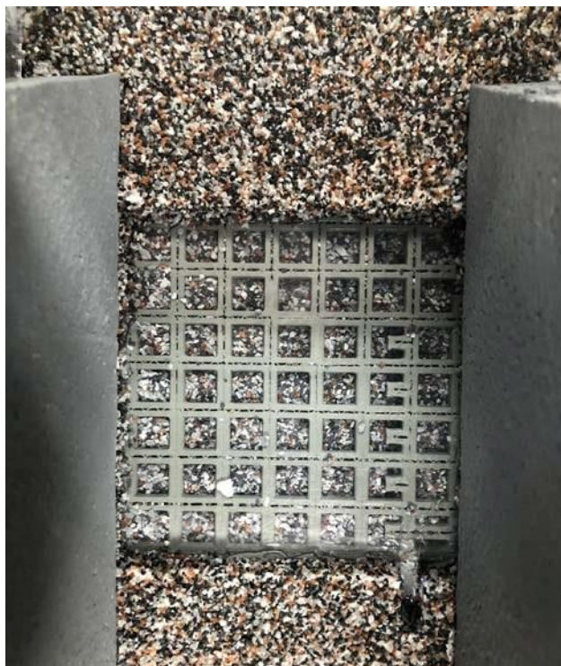
Fotografia 4 Detalhe do sistema de cruzetas para reforço do leito rochoso
