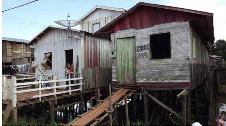
Fig. 4 - Habitação ribeirinha com vedações executadas a partir de tábuas verticais e horizontais, respectivamente.
