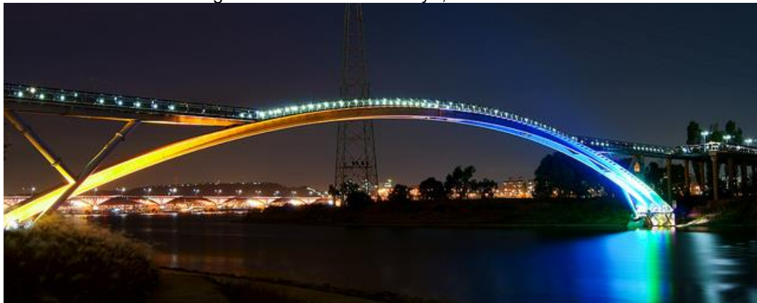
Figura 2 – Passarela Seonyu, Coreia do Sul
