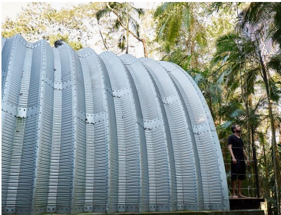
Figura 3: cobertura da Arca House vista de fora
