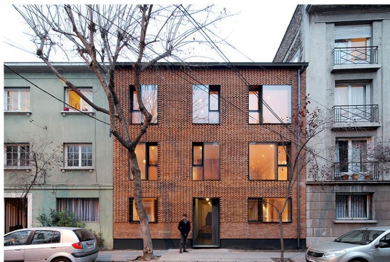
Figura 5: Fachada edifício e.RC por MAPA
