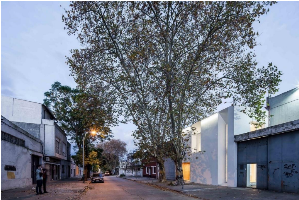
Figura 7: Residência Prinzi, fachada.
