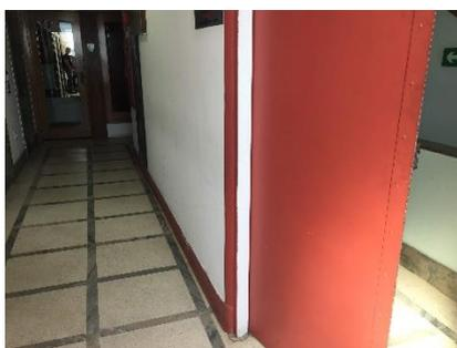
Figura 8: Pós reforma: Divisão hall de elevadores para pressurização das escadas, 2019
