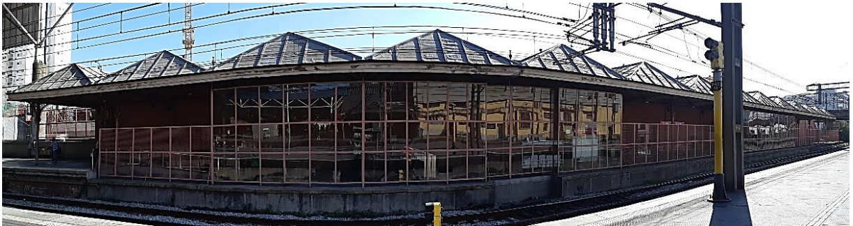
Figura 18: cobertura da estação Brás, similar à encontrada no catálogo MacFarlane's, acima.
