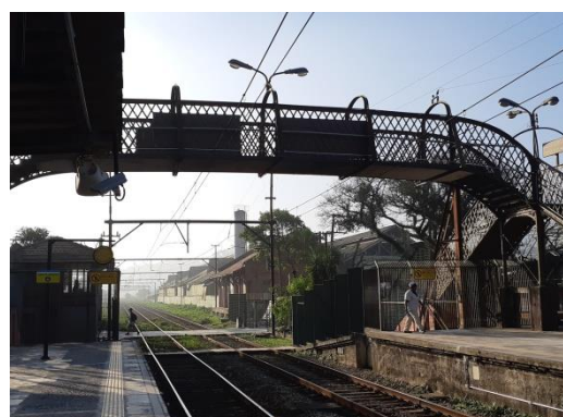
Figura 16: passarela encontrada na estação Ribeirão Pires. Foto: Izabela Salgado, 2019.
