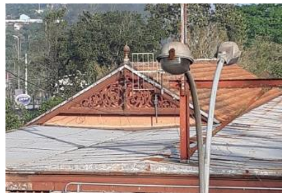
Figura 14: Empena decorativa de ferro fundido, estação Ribeirão Pires. Foto: Izabela Salgado, 2019.
