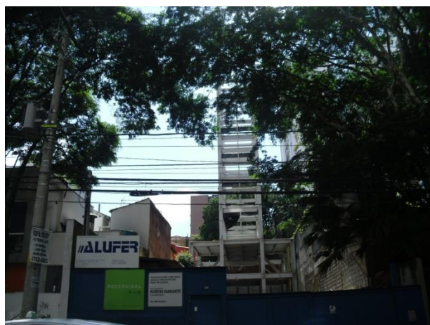
Imagem 13: Construção de um empreendimento da construtora Alufer
