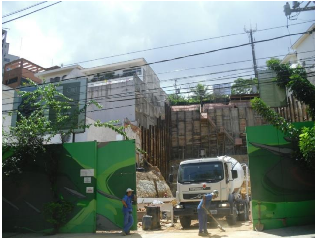
Imagem 16: Construção do Oka Building
