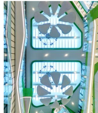
Figura 14: Aberturas Zenitais na cobertura
