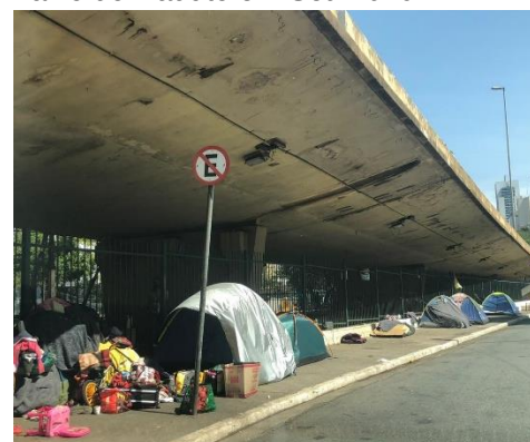
Baixo do viaduto em Set. 2020
