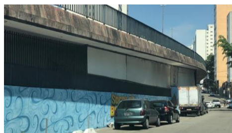
Baixo do viaduto em Set. 2020
