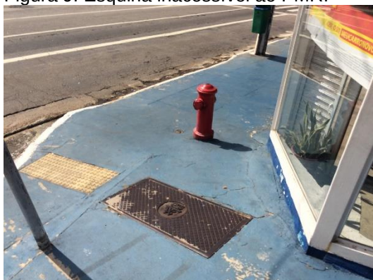
Figura 9. Esquina inacessível ao PMR:
