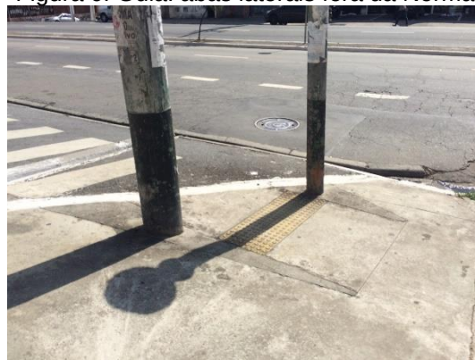
Figura 6. Guia: abas laterais fora da Norma:
