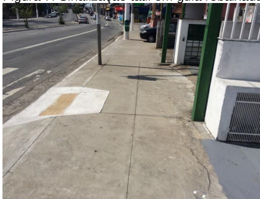
Figura 7. Sinalização tátil em guia rebaixada:
