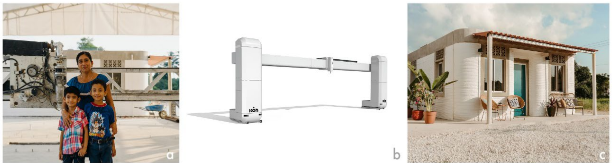
Figura 3 - Processo (a), impressora utilizada (b) e resultado da construção (c).
