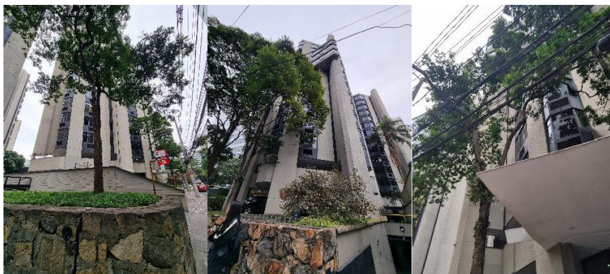
Figura 8: Fotos fachada Edifício Jafet. Fonte: da Autora (2025).
