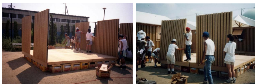
Figuras 8 e 9: Casas Paper Log, Kobe, Japão (1995); construção; Fonte: Shigeru Ban Architects (2024)
