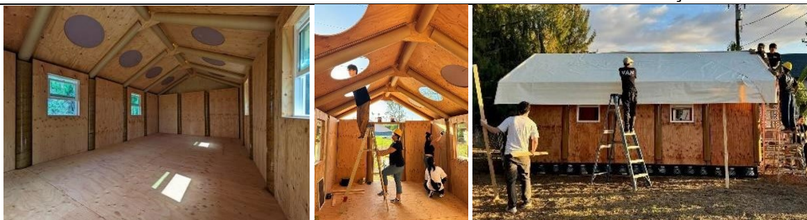
Figuras 18, 19 e 20: Casas Paper Log, Maui, Hawai (2023); obra temporária com tubos de papelão; Fonte: Designboom (2024)
