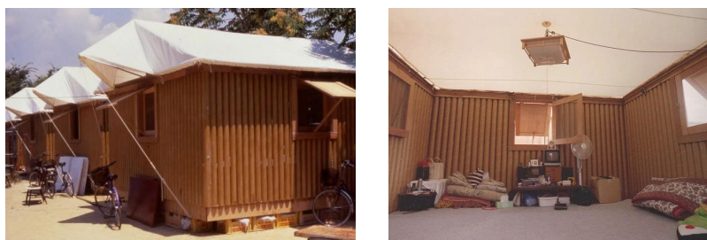
Figuras 6 e 7: Casas Paper Log, Kobe, Japão (1995); obra temporária com tubos de papelão Fonte: Shigeru Ban Architects (2024)
