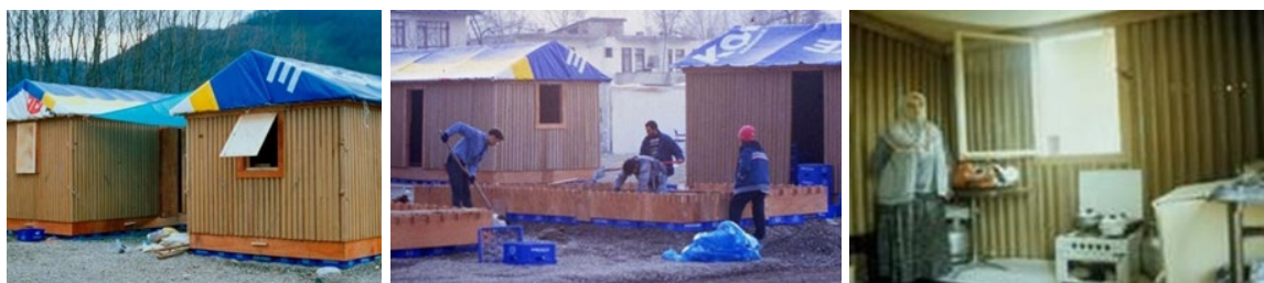
Figuras 12, 13 e 14: Casas Paper Log, Turkey, (2000); obra temporária com tubos de papelão Fonte: Shigeru Ban Architects (2024) e Architect Magazine (2024)
