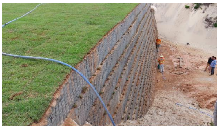
Figura 4: Muro verde na Lagoa da Conceição em solo reforçado - CASAN
