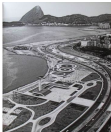
Figuras 11 / 12: Vista aérea / Vista aérea interna
