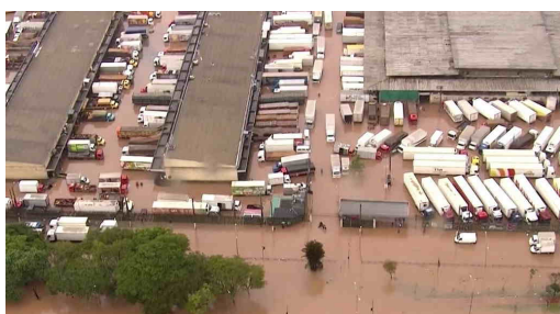
Figura 7: Inundação da CEAGESP, em 2020.
