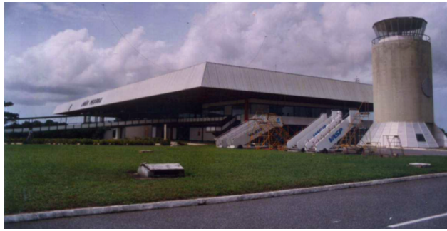
Figura 9 – Fotografia da torre de comando a direita e rampa de embarque a esquerda.
