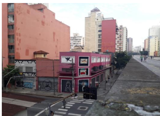
Figura 3 – Edifícios na Rua Marquês de Itu
