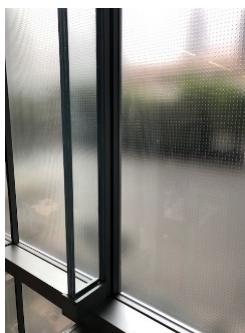
Figura 17: Detalhe da fachada
