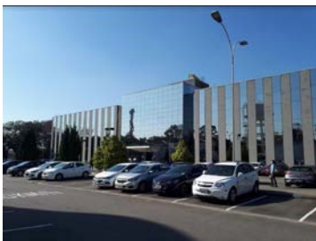
Figura 23: Edifício do Centro Tecnológico – fachada oeste
