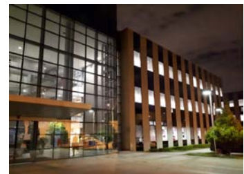
Figura 25: Edifício do Centro Tecnológico – fachada oeste
